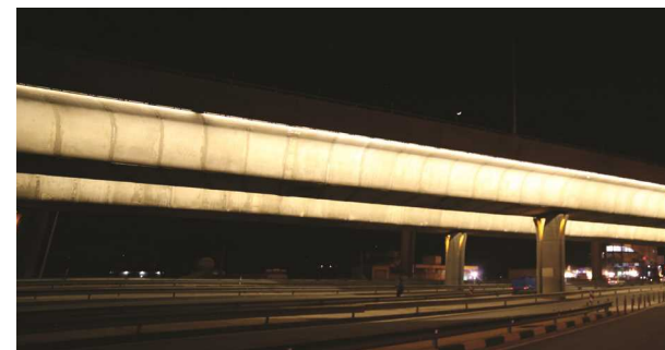
طراحی و اجرا نورپردازی پل کاروانسرای سنگی - تهران
