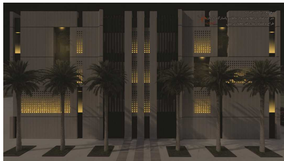
طراحی و اجرا نورپردازی ساختمان دفتر مرکزی فن آوری اطلاعات و ارتباطات پاسارگاد آریان - تهران (پردیس)
