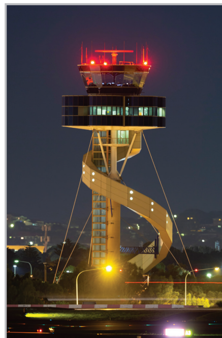
NAVI کنترل روشنایی فرودگاه ها
