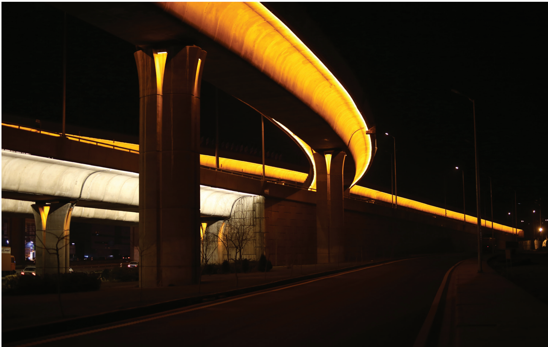
• طراحی و اجرا - پل کاروانسرای سنگی / جاده مخصوص کرج تهران
