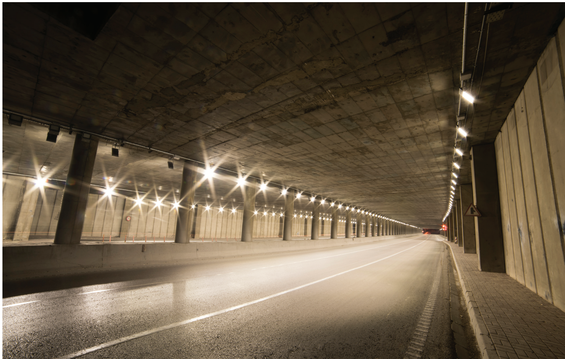
• اجرا - زیرگذر همت / اصفهان
